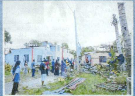
ORANG ramai melihat rumah rosak teruk dalam kejadian ribut, di Kampung Sungai Baru, Jalan Kuala Sungai, semalam.
